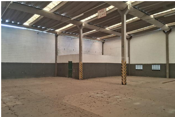
VISTA PARCIAL INTERNA DO IMÓVEL
