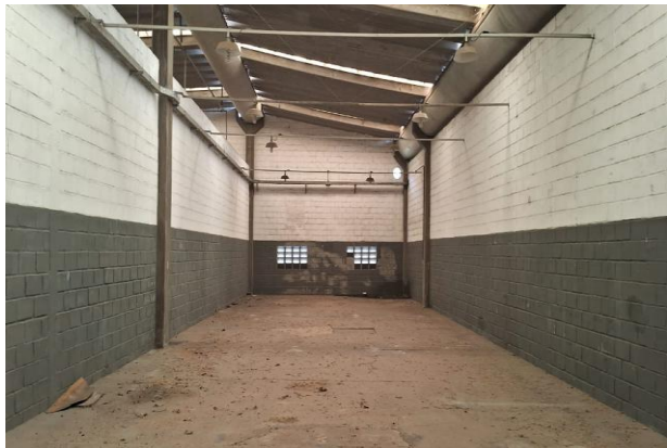
VISTA PARCIAL INTERNA DO IMÓVEL
