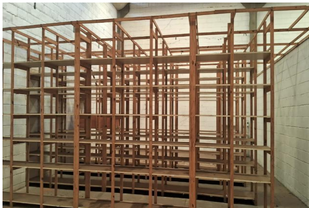
VISTA PARCIAL INTERNA DO IMÓVEL
