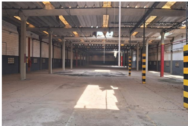
VISTA PARCIAL INTERNA DO IMÓVEL
