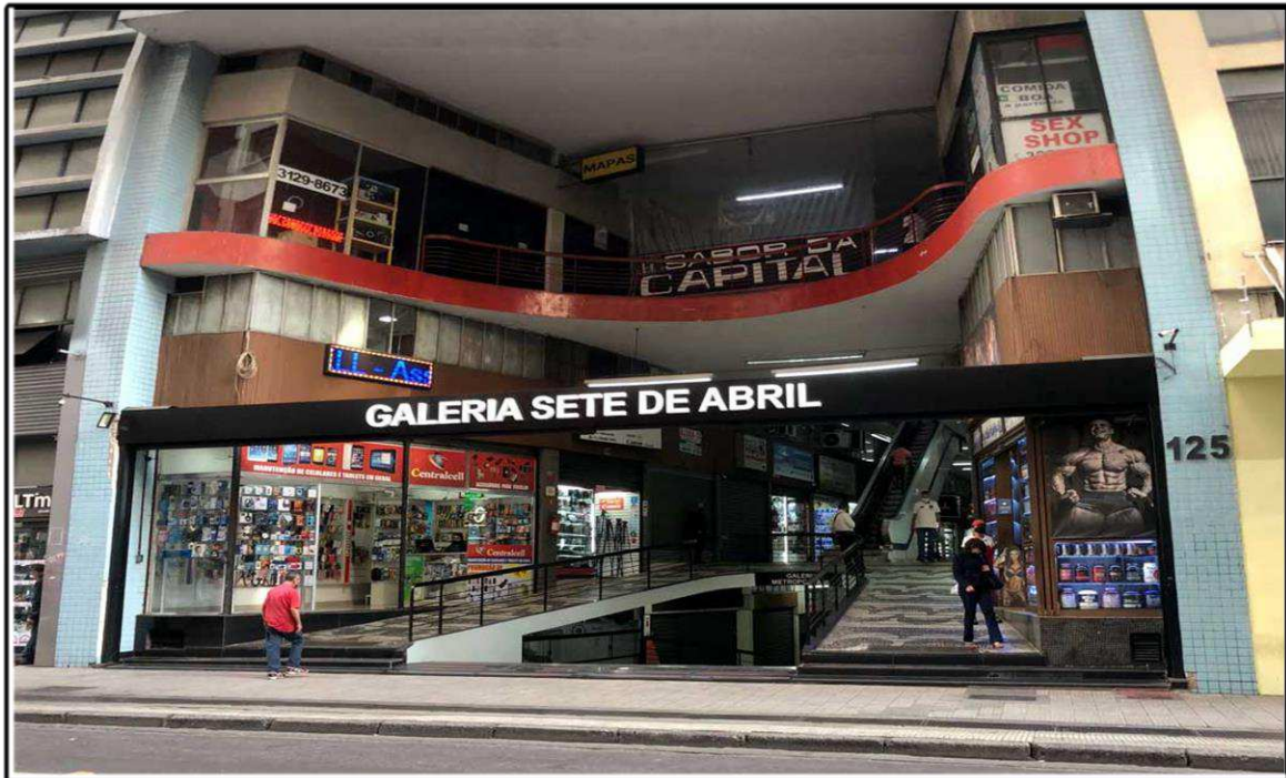
Vista da fachada frontal da galeria onde imóvel objeto da ação está localizado, tomada da Rua Sete de Abril.
