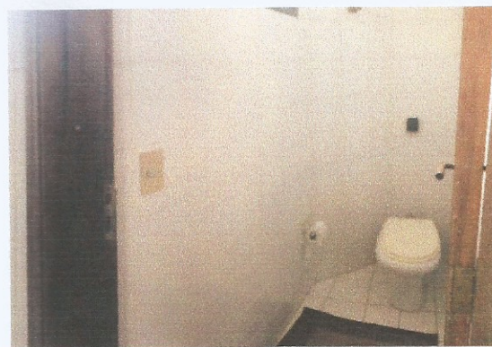
Figura 35 – Banheiro de apoio ao pavimento superior.
