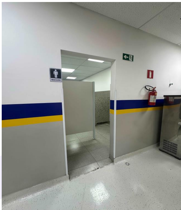
Imóvel avaliando - Foto 7
