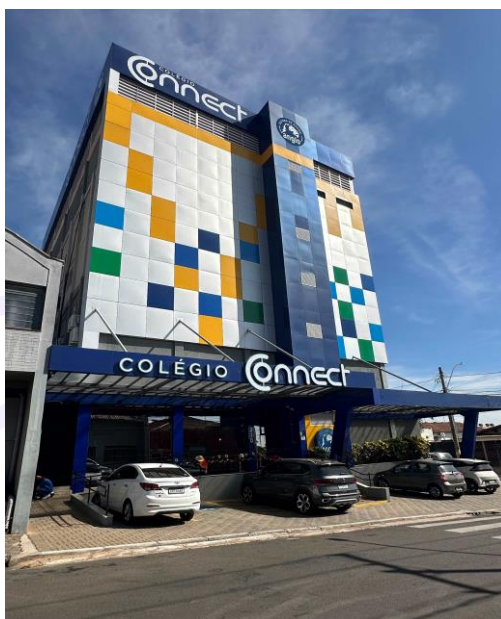
Fachada do imóvel - Foto 1
