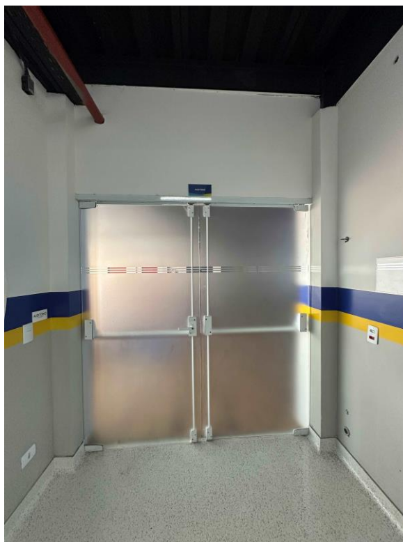
Imóvel avaliando - Foto 18
