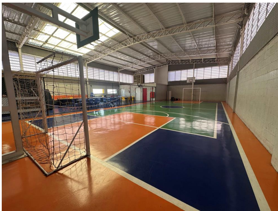
Imóvel avaliando - Foto 21
