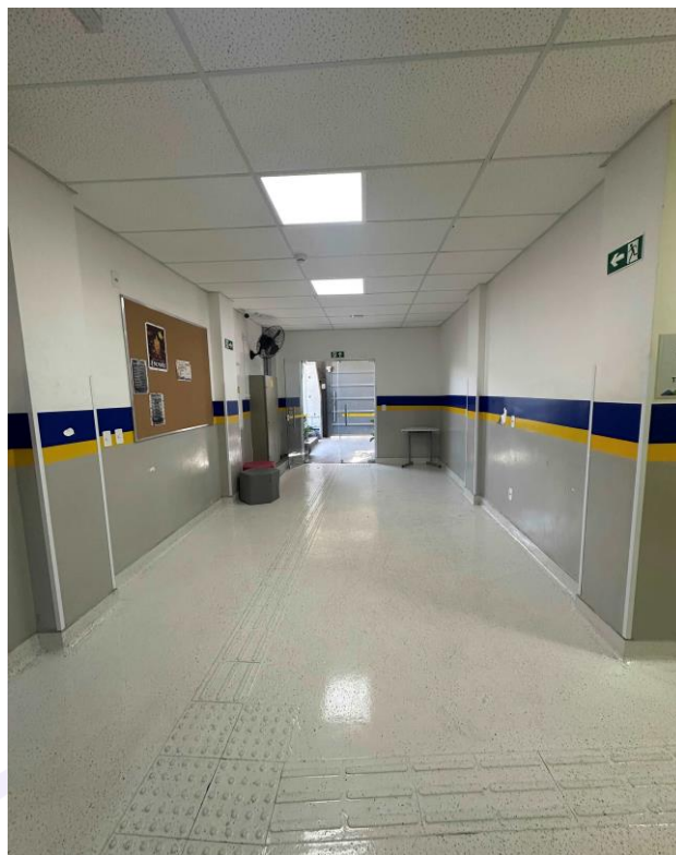
Imóvel avaliando - Foto 13
