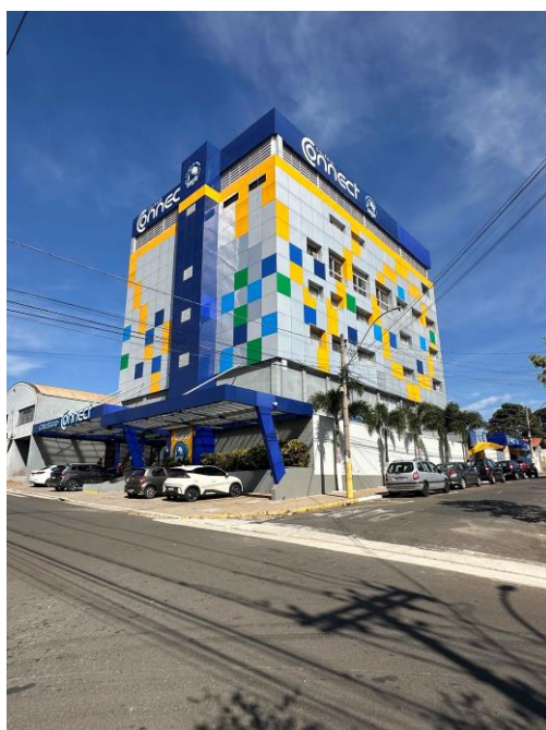
Fachada do imóvel - Foto 2
