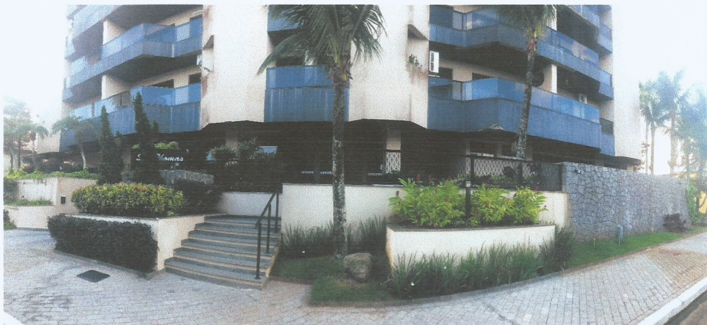
Figura 6 - Vista da entrada do edifício.
