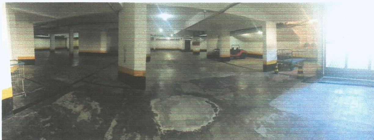
Figura 39 – Área de Garagem subsolo.
