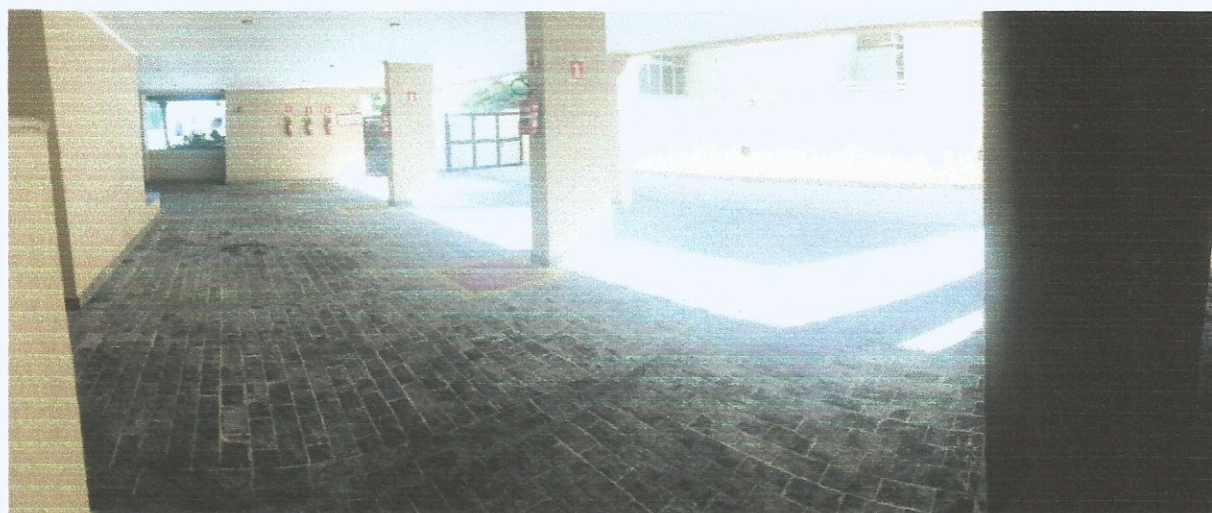
Figura 40 – Área de Garagem Térreo.
