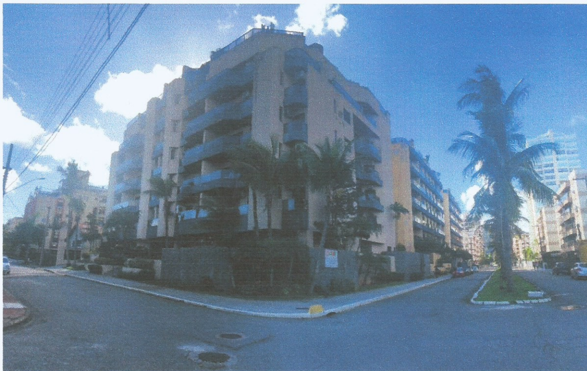
Figura 4 – Vista do Edifício Saint Thomas, Esquina das ruas Maria Martha Arruda Estefano e Rua Chile.
