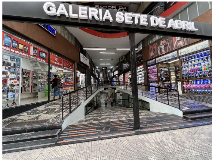
Foto 8- Rampa de acesso pela Rua 7 de Abril desce para a Galeria Metropolitana
