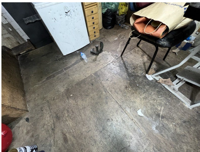
Foto 21- Vista do piso de madeira do mezanino
