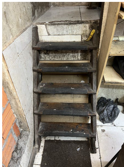
Foto 15- Escada de madeira para acesso ao mezanino da loja 9
