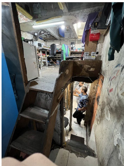
Foto 17- Mezanino da loja com estrutura de madeira
